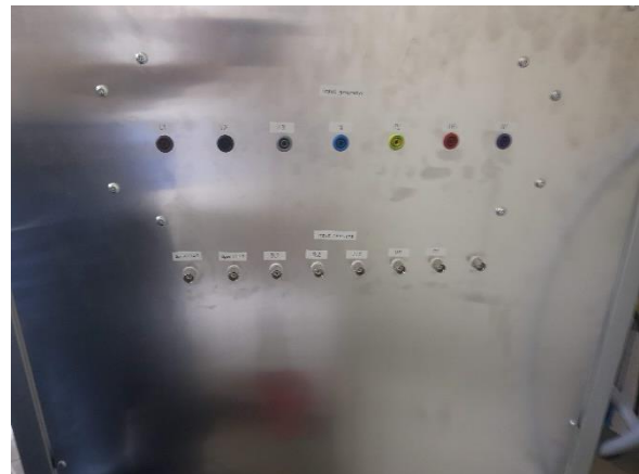
Figure 4 Face de droite du banc de test
