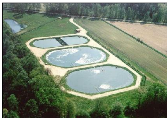
Figure II.8 : lagune aérée. [source :Lemang.S, 2001]
