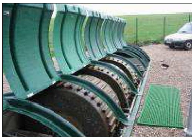
Figure II.7: disque biologiques Step de Rogéville – 54.
