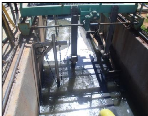
Figure III.6 : Le dessablage-déshuilage (22/05/2012)
