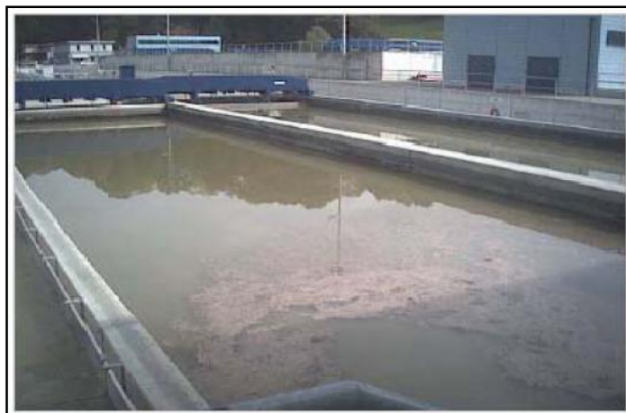
Figure II.3 : Décantation primaire et flottation [Deshayes, 2008]
