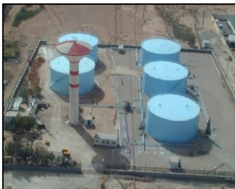
Figure I.4: Photographie Station de stockage et de distribution d'eau principale. [SHSH ,2012]
