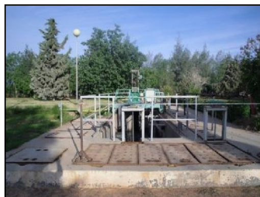
Figure III.6 : Le dessablage-déshuilage (22/05/2012)
