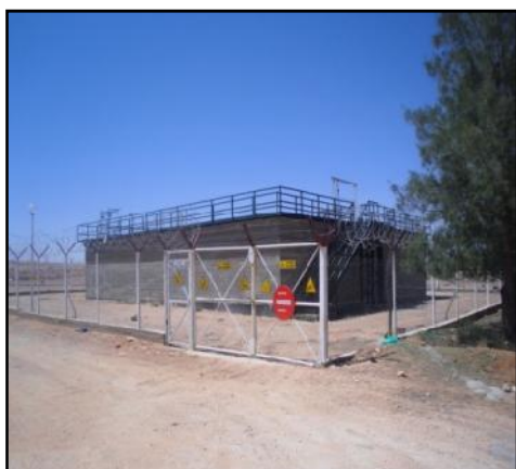
Figure III.2: Bassin de régulation
