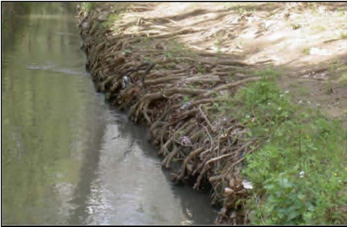
Figure II.8 : Aménagement des berges de l'oued contre le glissement ( Halouche, 2007 ).
