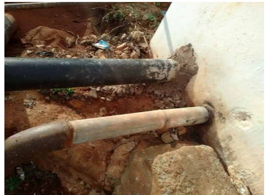
Fig.2.6 Conduite en acier enrobée 102/114
