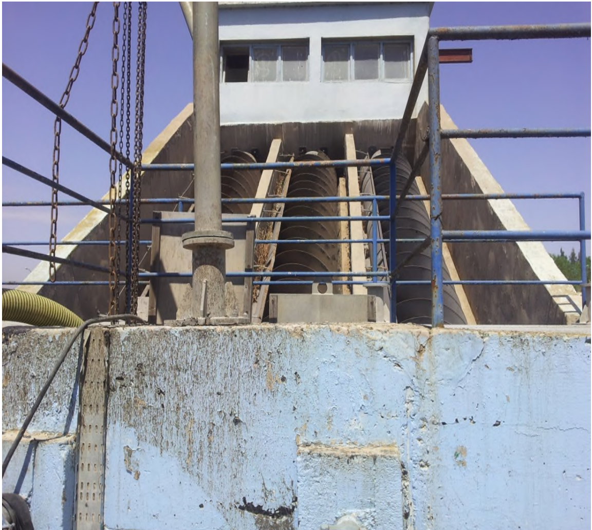
Figure II.12 : vis de recirculation de boue.
