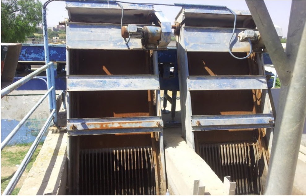
Figure II.5. Grilles mécaniques.
