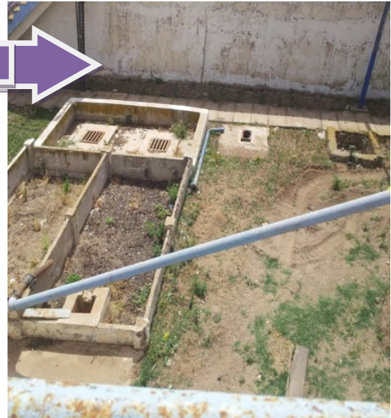
Figure II.9. lit de séchage
