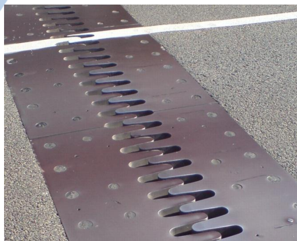
Figure 4.5. Joint à peigne à dents arrondis
