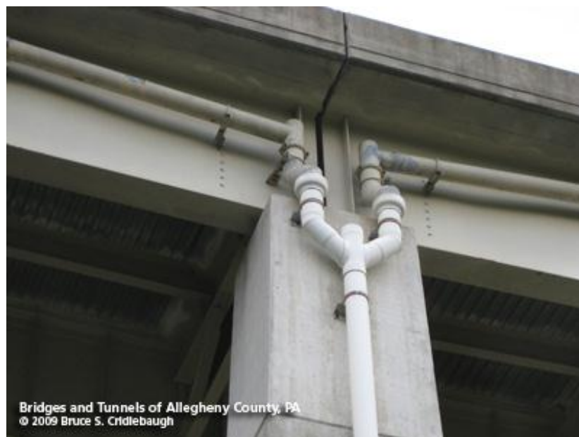
Figure 5.5. Système d'évacuation des eaux sur un pont.
