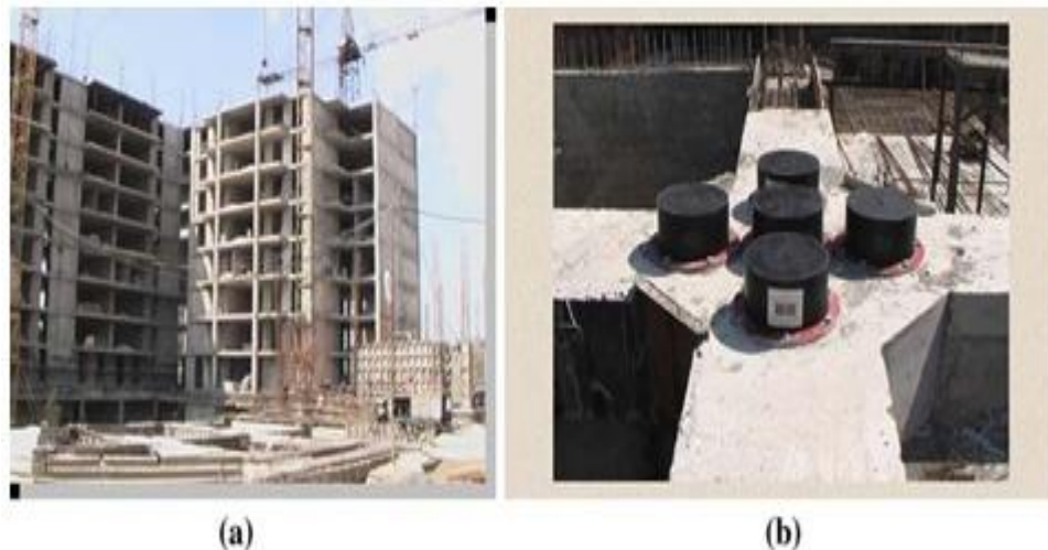
Figure I.16: Bâtiment isolé à la base à Yerevan (Arménie)
