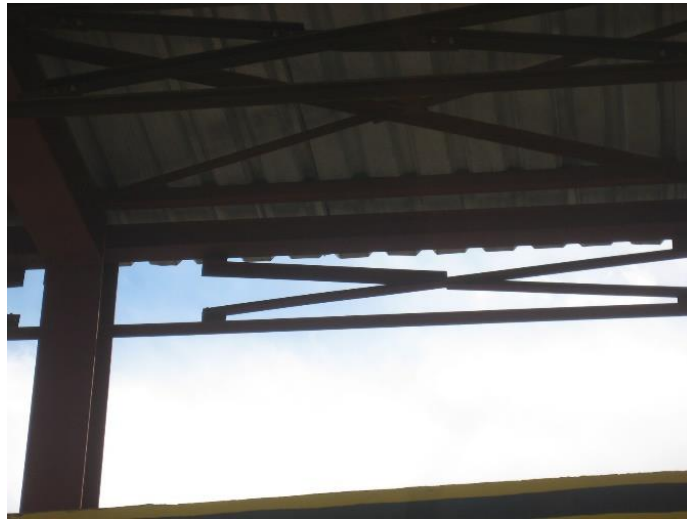
Figure II. 48 : Contreventement métallique
