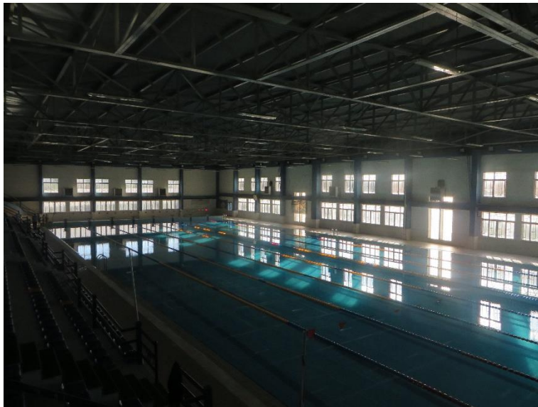
Figure II. 11: Vue à l'intérieur de la piscine
