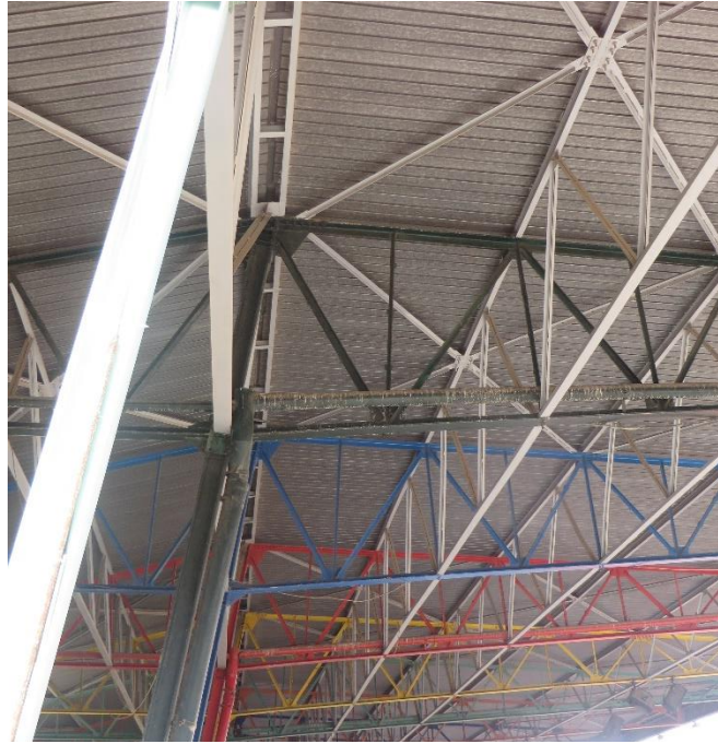
Figure II. 2 : Charpente métallique de la tribune du stade Akid Lotfi
