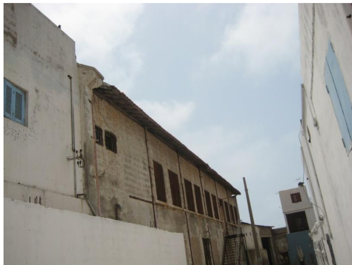
Figure II. 15 : Vue de l'extérieure du marché
