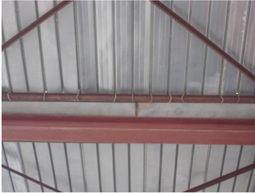
Figure II. 46 : Les crochets de fixations de la toiture
