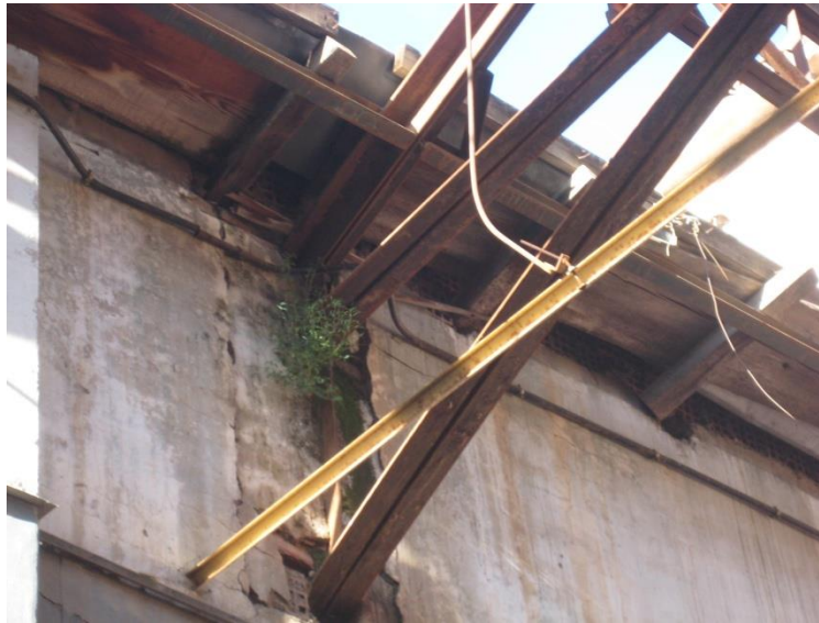
Figure II. 37 : Apparition de plante et de lichens
