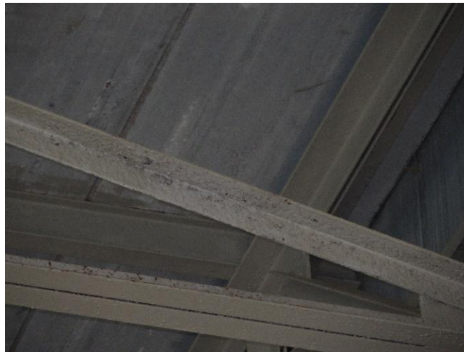
Figure II. 14: Rugosité d'élément de la toiture
