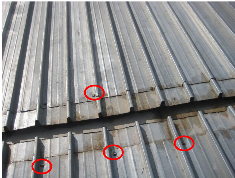
Figure II. 47 : Les vis de fixation de la toiture
