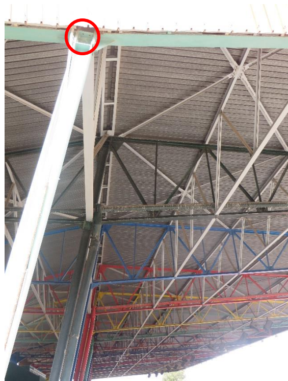
Figure II. 4: Raidisseur au niveau du poteau
