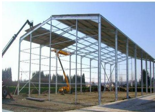
Figure I. 1 : Hall métallique en construction [2].
