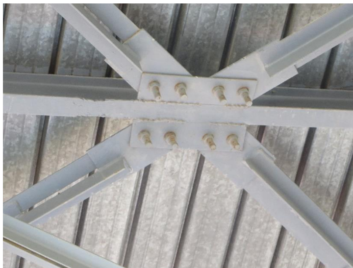
Figure II. 8: Corrosion sur les boulons du contreventement horizontal
