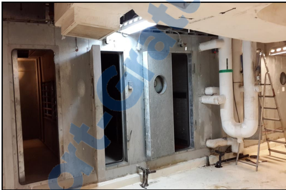
Figure 03 : Plénum de mélange (Benhadj.A ; 2014)
