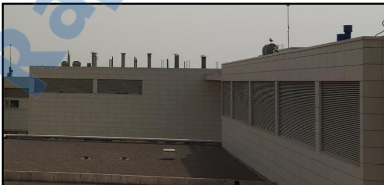
Figure 10 : Grilles de sortie d'air (Benhadj.A ; 2014)
