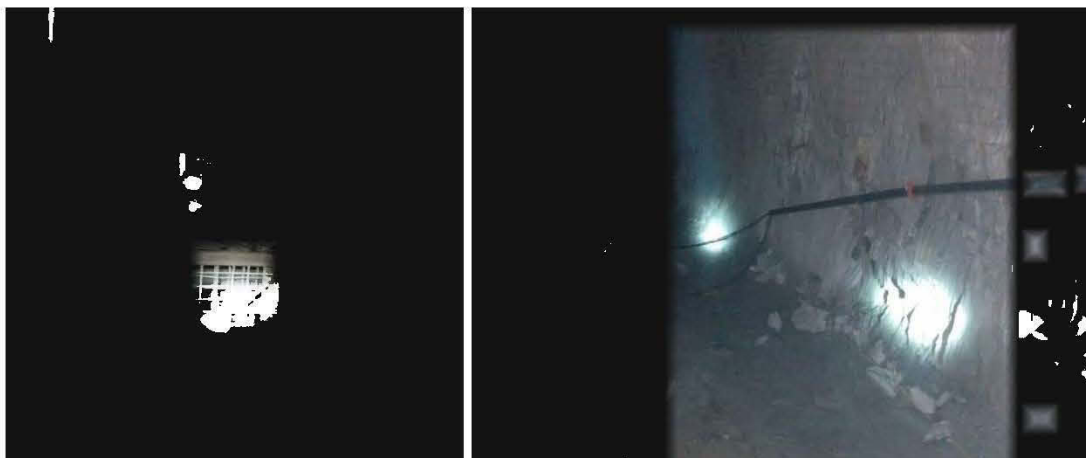
Figure 3-27 Cages instrumentées dans le chantier #83
