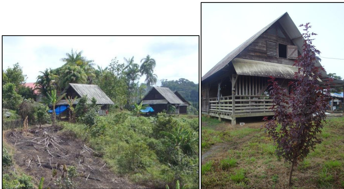
Photo 9. Les logements sociaux du bourg de Camopi
