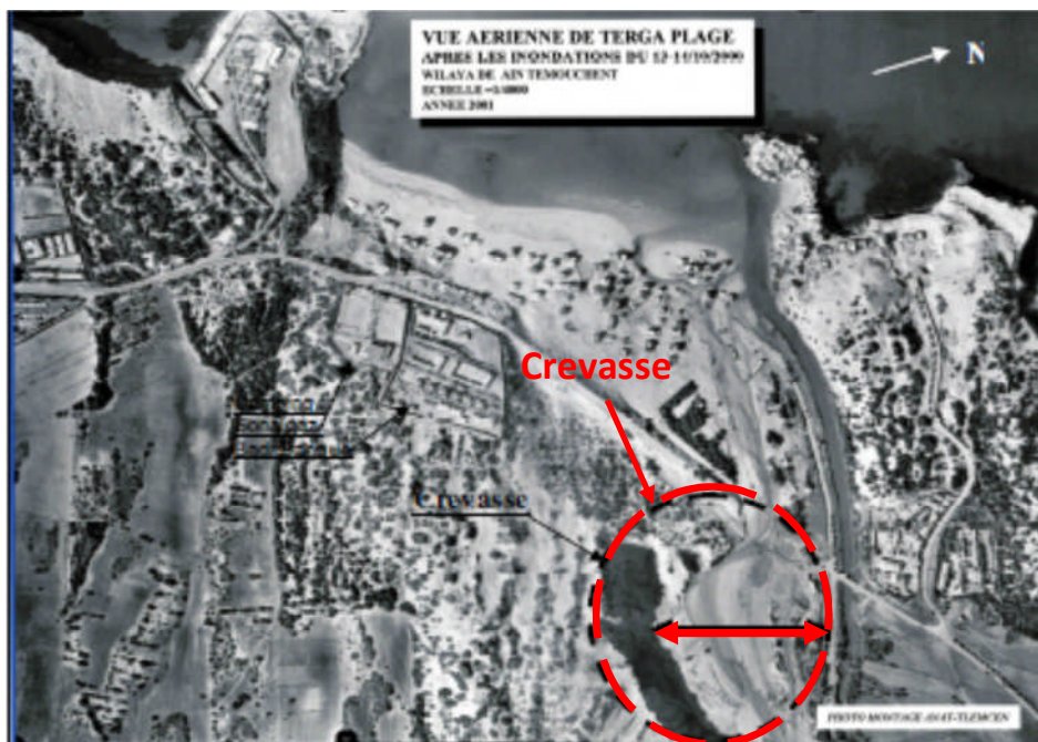
Fig. 3.11 Elargissement de l'oued Mallah dû à l'extension de la sablière [22]
