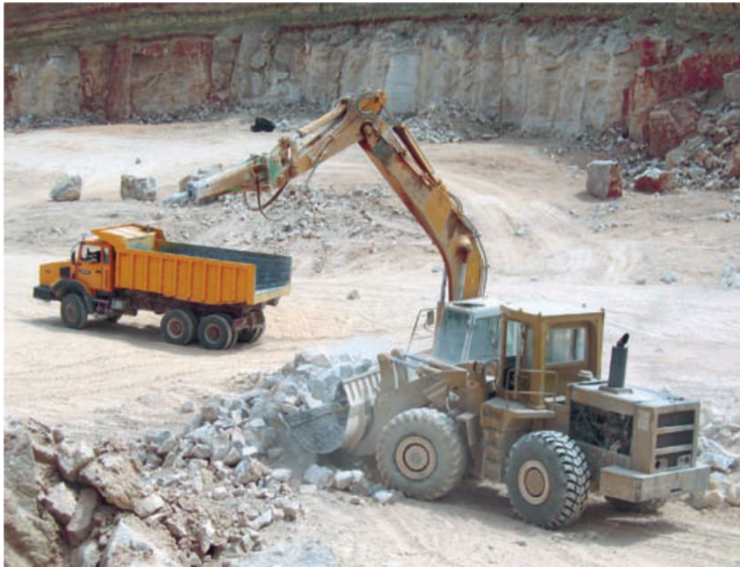
Fig. 1.2 : Exploitation d'une carrière. [7]
