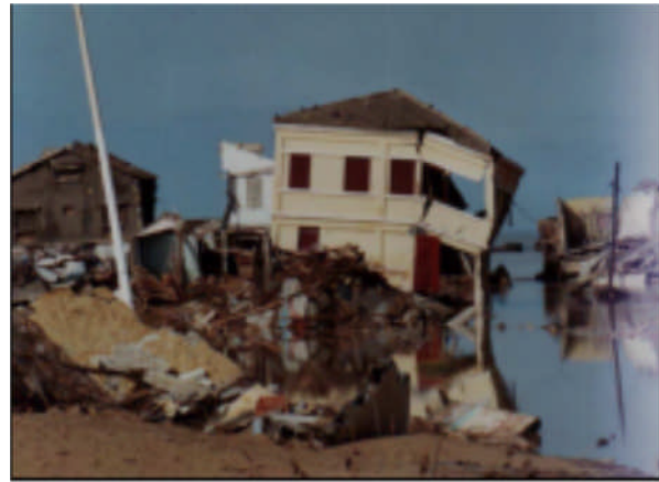
Fig. 3.10 Cabanons détruits par les inondations (14/10/2000) [22]
