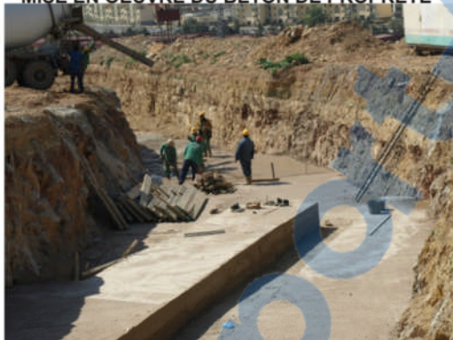
MISE EN OEUVRE DU BÉTON DE PROPRIÉTÉ
