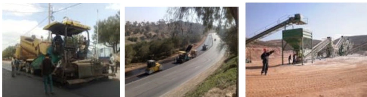
Fig. 2.39: Travaux routiers et station de concassage - STARR
