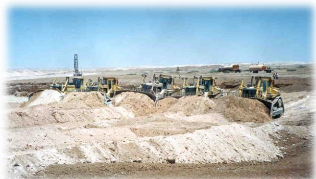
Figure 8 : opération de décapage par bulls
