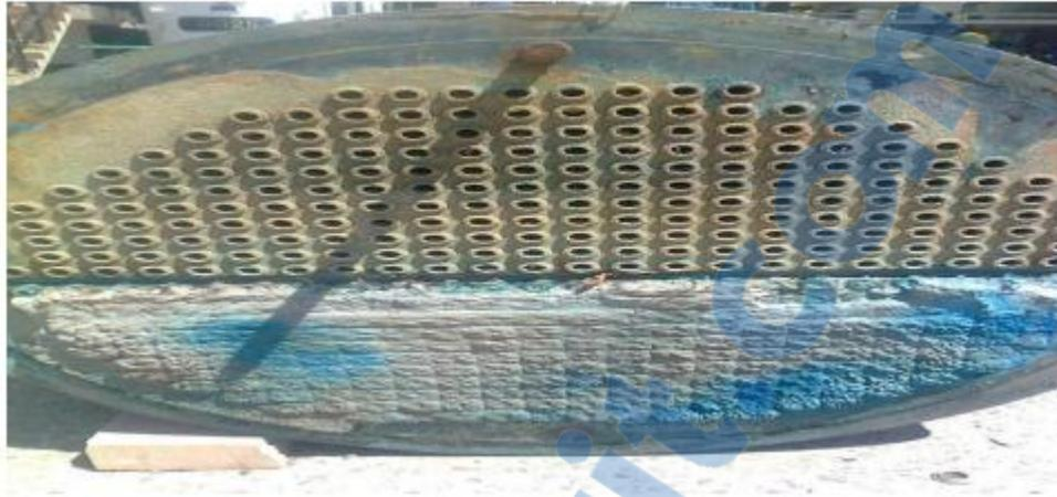
Figure I.26. Dépôt la tartre formée sur les faisceaux tubulaires de l'échangeur
