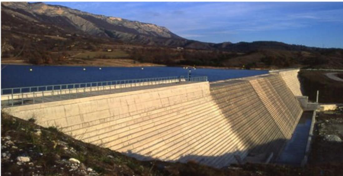
Figure I-4 : Barrage du Riou-BCR
