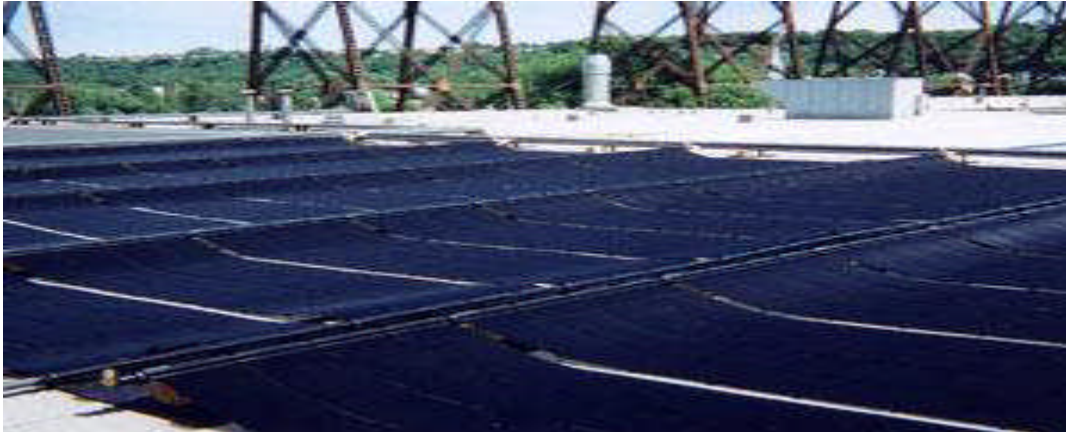
Figure III.3 : Capteurs solaires sans vitrage [49].
