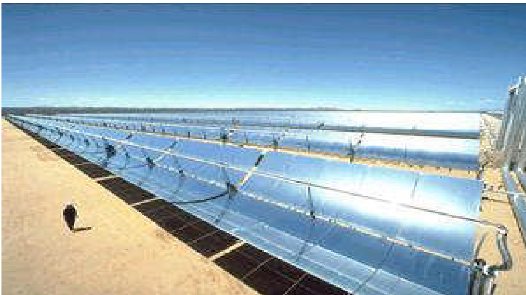
Figure III.9 : Système à réflecteur cylindro-parabolique [46].
