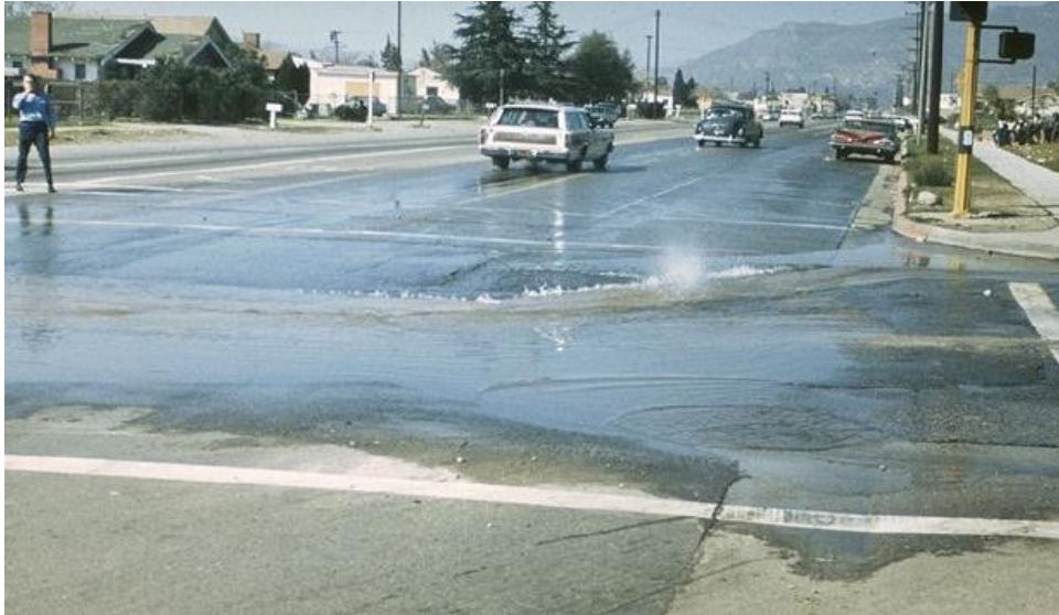
Figure 2-15 : Fuite de gaz suite au cisaillement du sol. San Fernando, 1971
