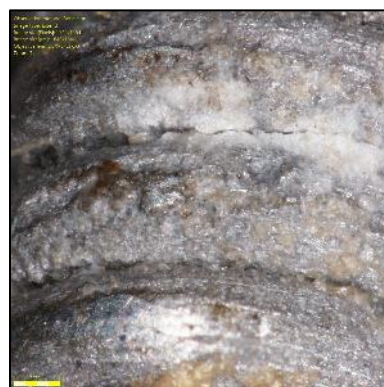
Figure 39 : Gros plan, corrosion par piqure généralisée, ©C. Despland, HE-Arc
