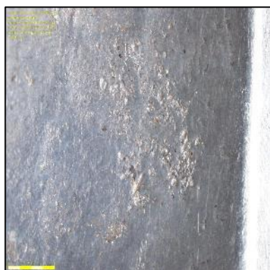
Figure 37 : Corrosion par piqûres, ©C. Despland, HE-Arc
