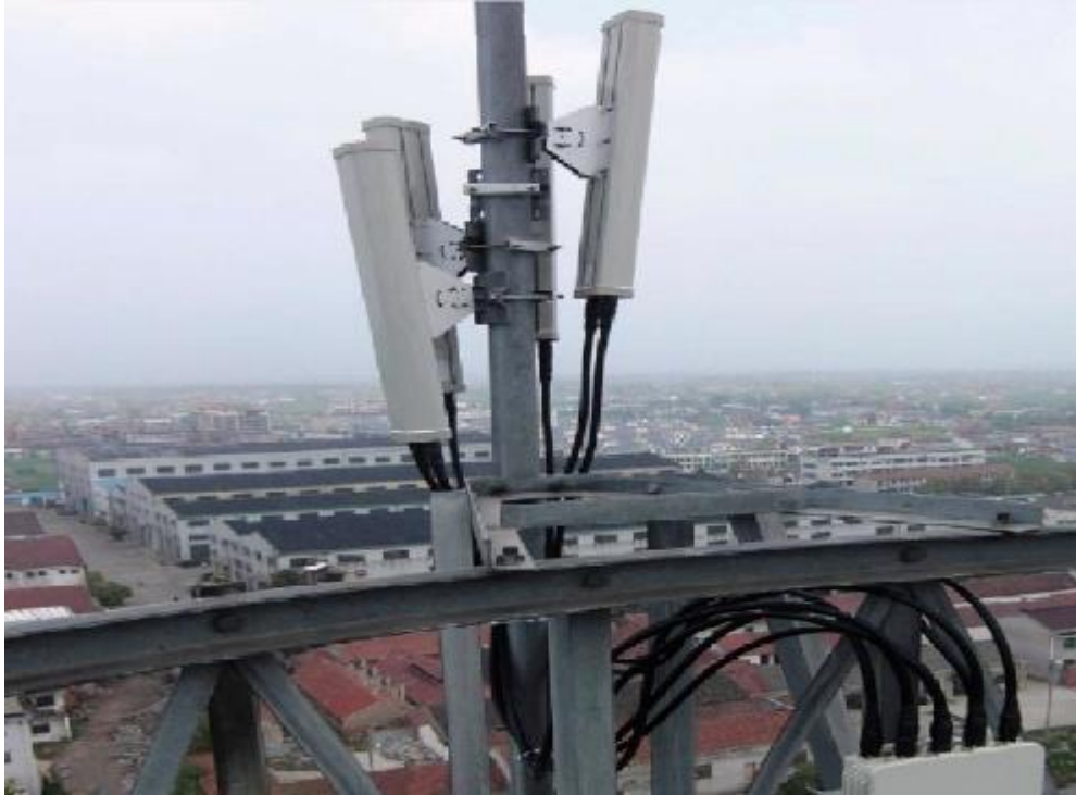
Figure 21 : couverture sectorielle avec une A8n
