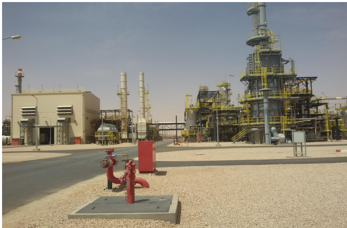
Figure I.6 : Unité boosting du CPF de la région de Rhourde Nouss [25]
