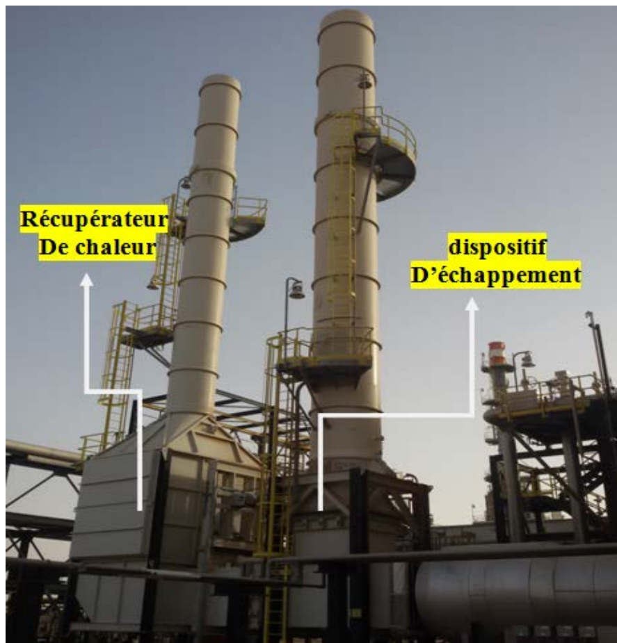
Figure V.4: Dispositif de régénération des gaz d'échappements de la SGT-400 utilisé pour de l'huile [25]
