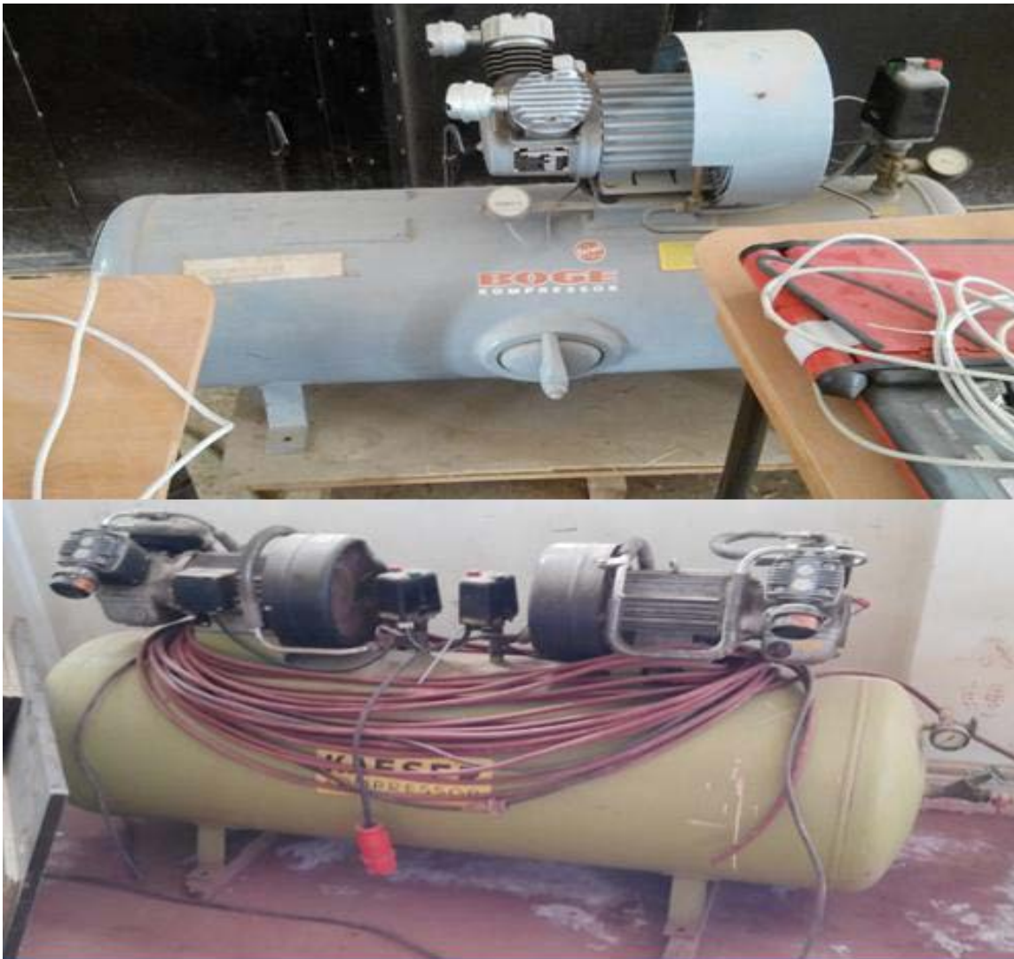
Figure I.15 Compresseurs à pistons
