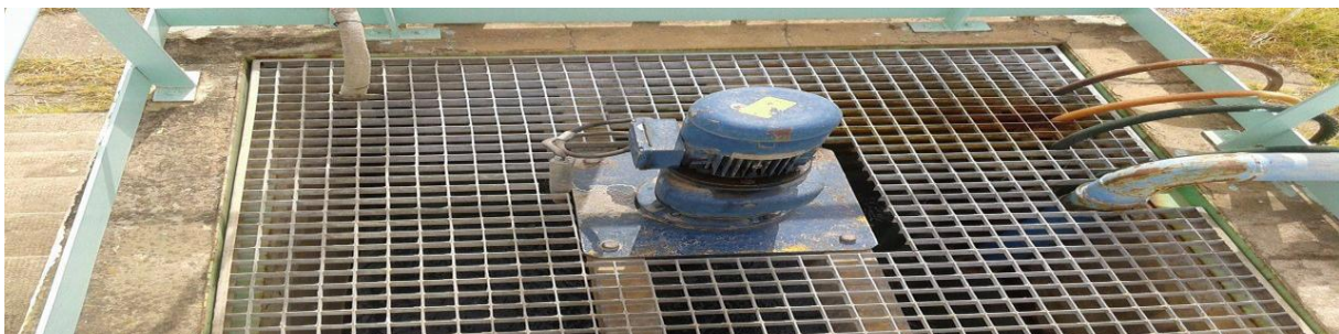
Image 5 : Le système permettant l'ajout de coagulant
