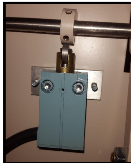
Figure II. 7 : Capteur de sécurité.
