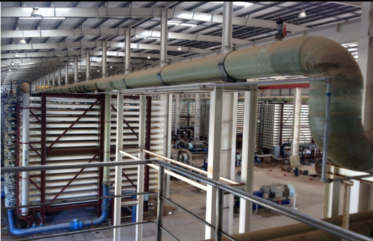
Figure 12 la section d'osmose inverse
