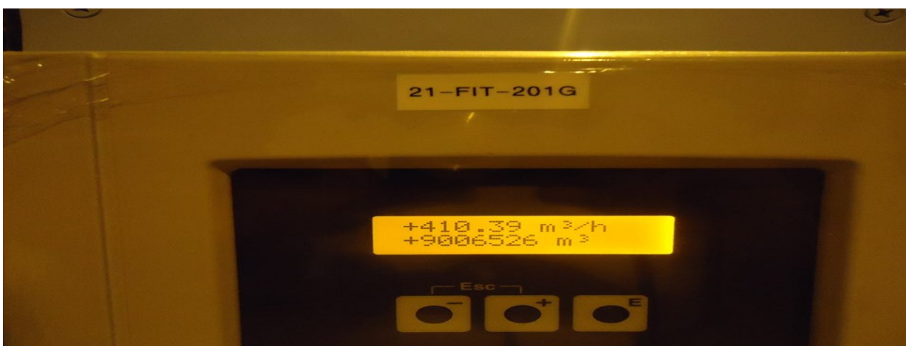
Figure 60 débitmètre du perméat
