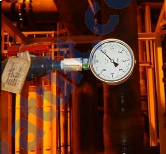
Figure 62 Manomètre du perméat
