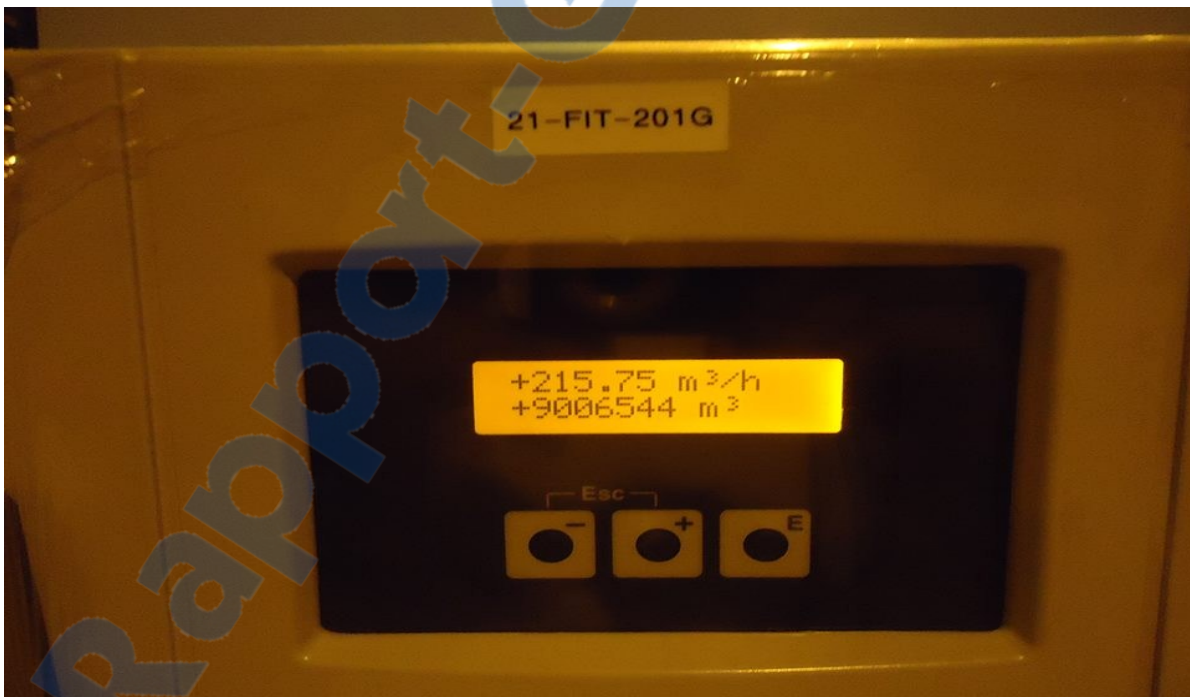
Figure 63 Débitmètre du perméat
