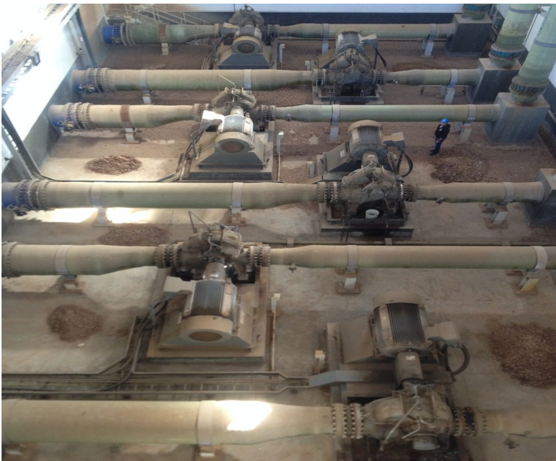
Figure 5 Station de pompage de l'eau de mer vers l'UF
