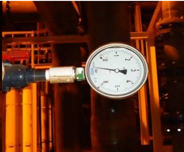
Figure 59 Manomètre du perméat
