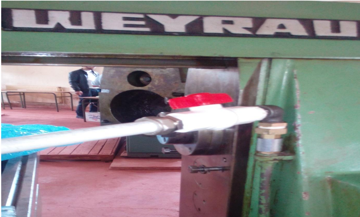
Figure IV.6 installation des accessoires du circuit de l'lubrification
