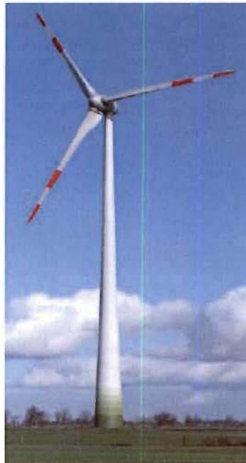
Figure 2.5 Éolienne à axe horizontal (3MW) [13]
