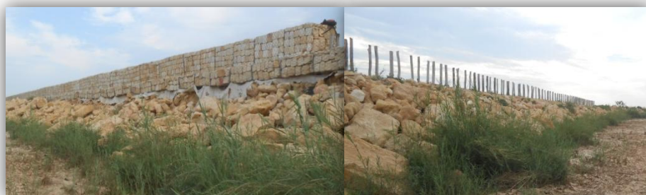
Photo 3 : La digue (intacte à gauche, démantelée à droite)
