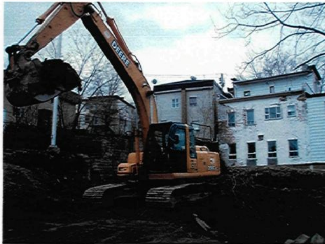
Figure 17 MéliSSa Santerre, Intervention citoyenne , Chicoutimi, 2009. Démolition d'un espace public (parc) derrière chez moi pour en faire un stationnement. Ville Saguenay n'a averti aucun citoyen avant de débiter les travaux de démolition du parc.
