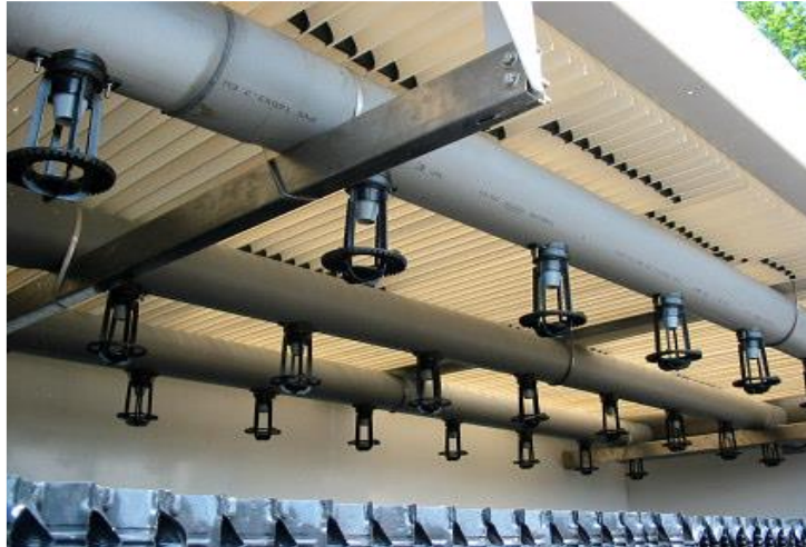
Figure II.24 : Système de dispersion du fluide à refroidir
