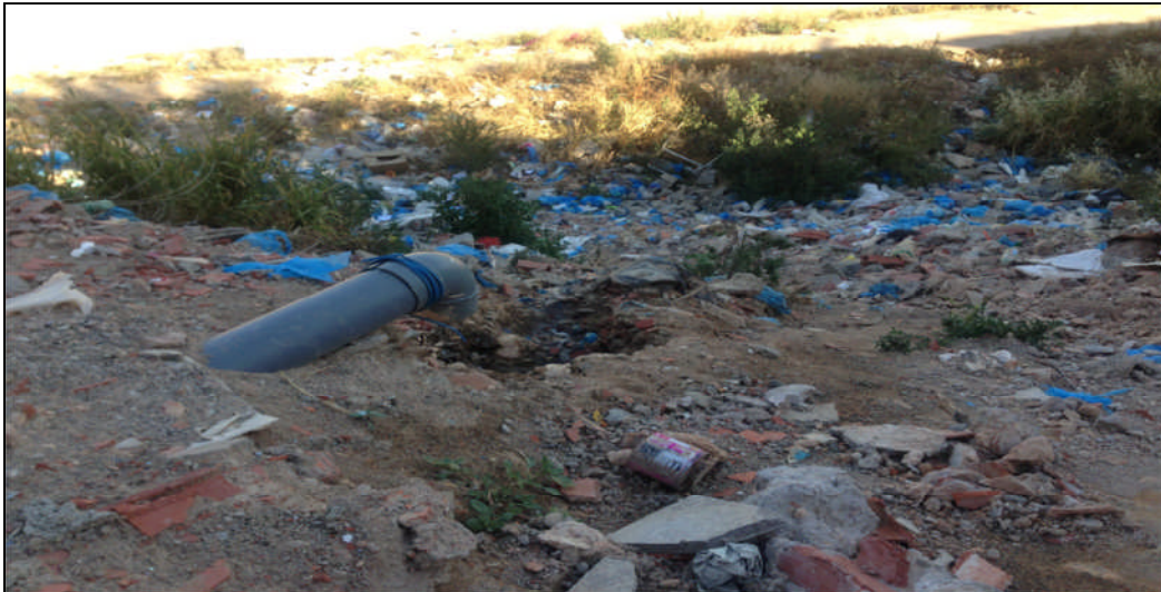
Figure 2.14: L'état catastrophique de réseau d'assainissement dans la plaine de Maghnia (Photos Draou S., 2013).
