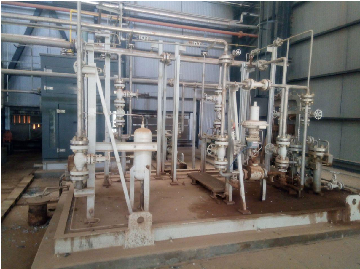
Figure.III.18. Circuit d'huile d'étanchéité.
