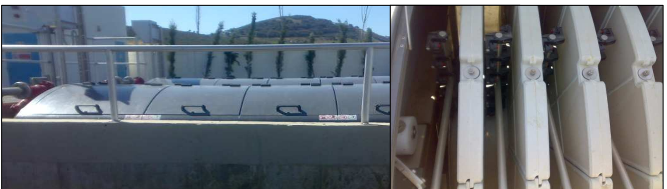
Photo 7 : Filtre à tamis rotatif (10µm)
