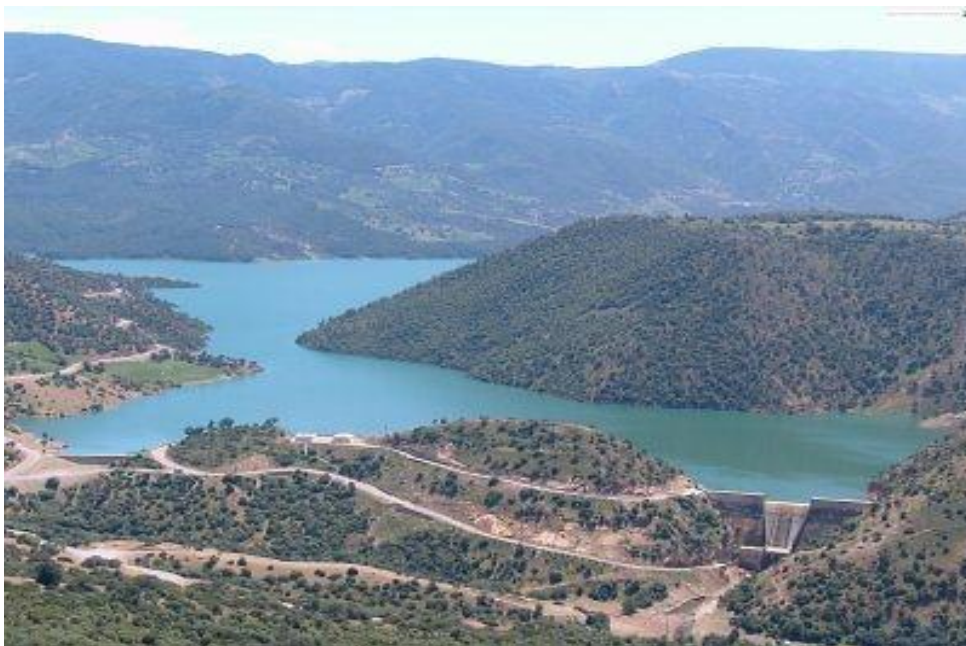
Fig2 : Barrage Bab Louta prise par CDF Tahla
