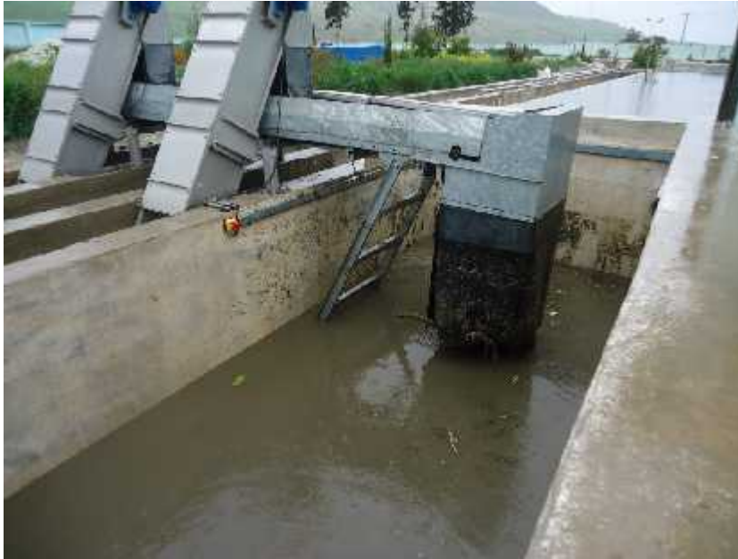
Figure II.1: STEP de Ain El Tolba le 24 /03/2015 problème de colmatage à l'entrée du STEP
