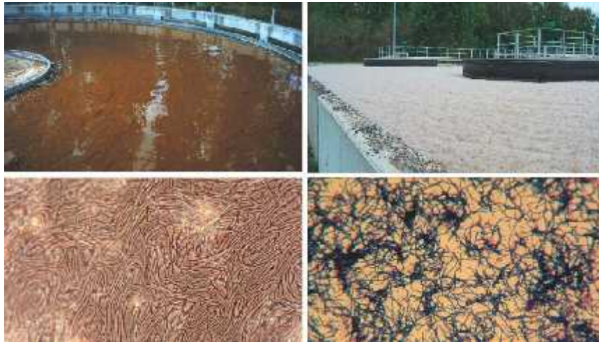
Figure II.2 : Dysfonctionnements biologiques : voile de boues élevé dans un clarificateur dû à la prolifération de Microthrix parvicella (à gauche) et mousses stables en surface d'un bassin d'aération dues à la prolifération de Mycolata (à droite) [source : www.cairn.info ]
