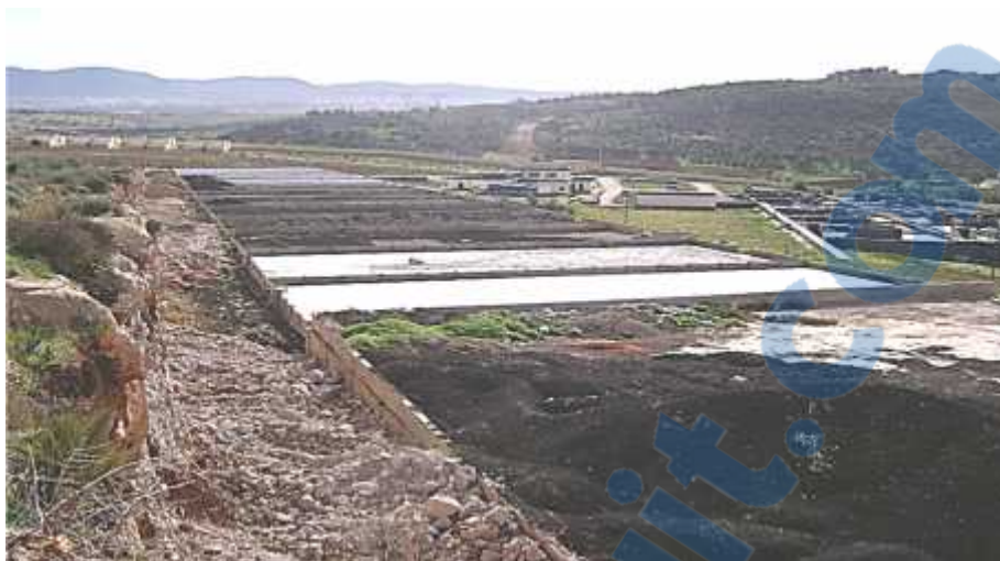
Figure III.13 : Lits de séchage +Aire de stockage
