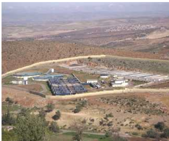
Figure III.2 : Photo Panoramique de la STEP de Ain El Houtz-Tlemcen
