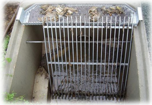
Figure II.1 dégrilleur manuel [28].
