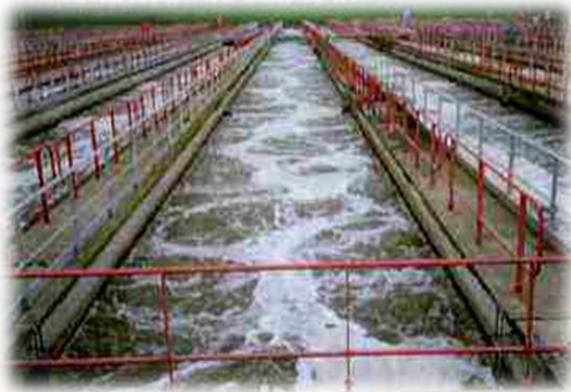
Figure II.3 l'injection de l'air dans un dégraissage-déshuilage rectangulaire [32]
