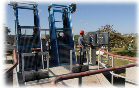
Figure II.2 Dégrilleur automatique [29].
