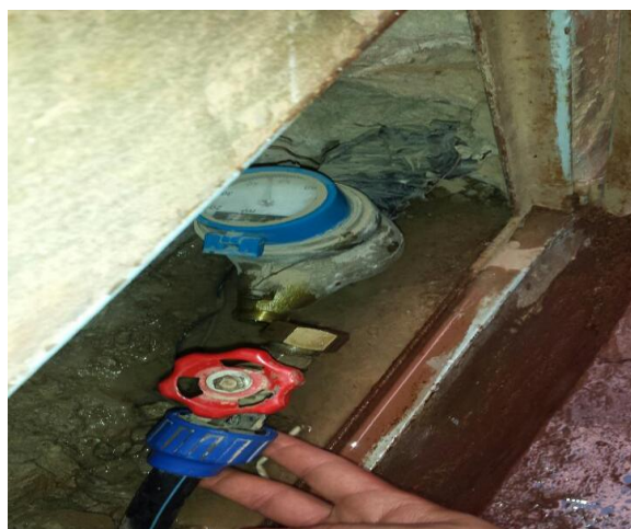
Figure V. 8 : Désassemblage de la conduite d'arrivée d'eau
