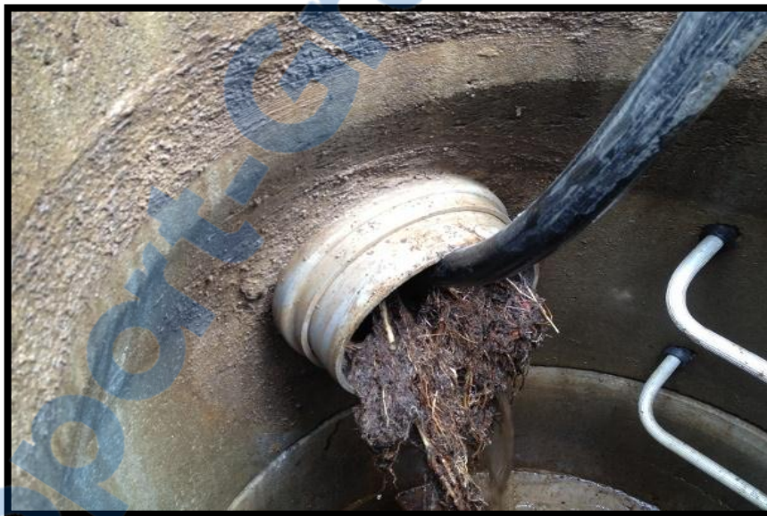
Figure .III.3 : curage de conduite [25].
