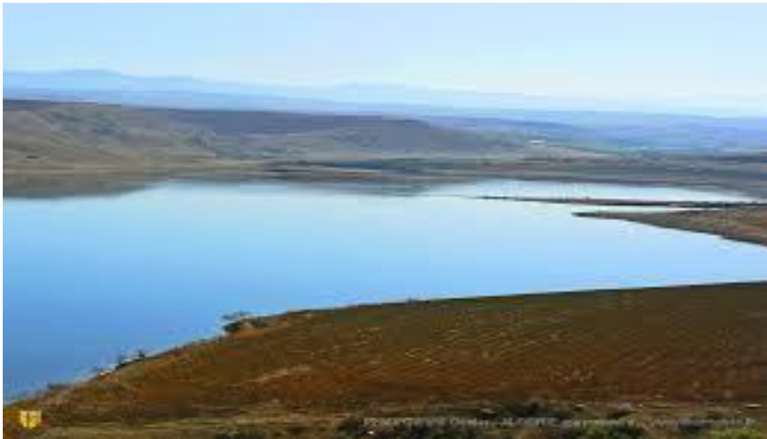
Figure 15: Vue sur la cuvette du barrage Sikkak
