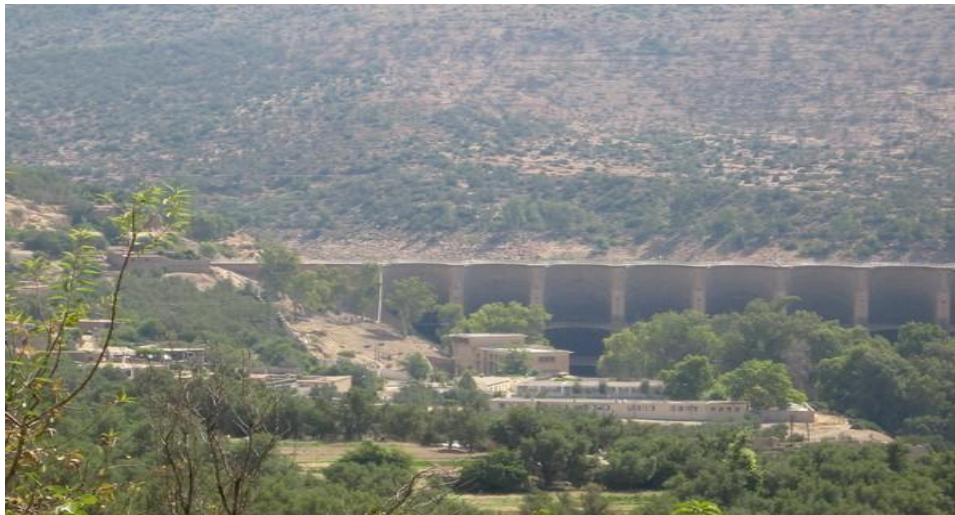
Figure 5 : Vue de face du barrage de Béni Bahdel
