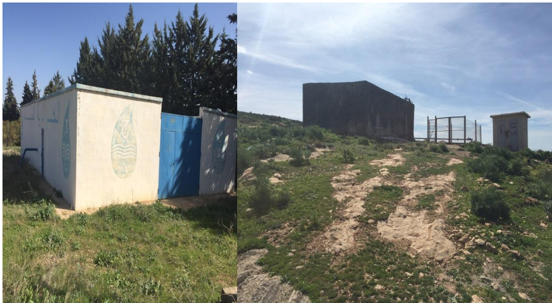
Figure III.8: Photo montrant les deux types de périmètres de protection en dur à gauche et en léger à droite (forage Mansourah et Beni Mester 'Chemoul')
