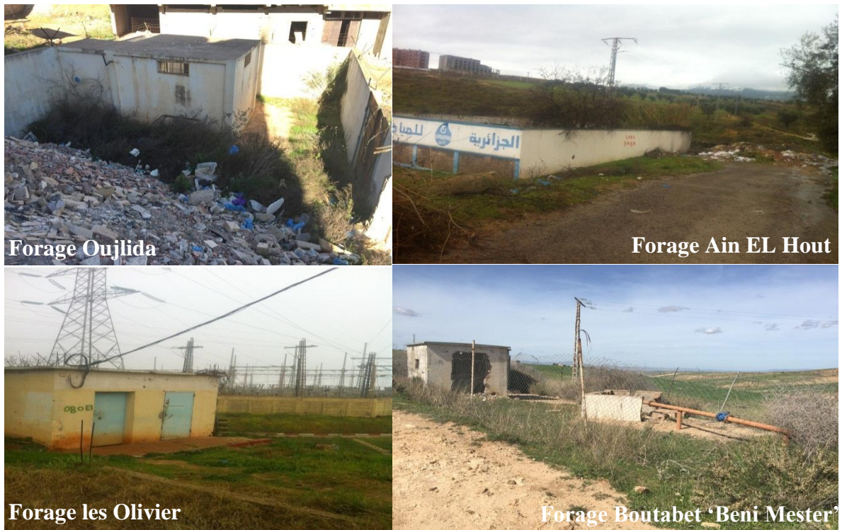
Figure II.10: Exemple des forages visités.
