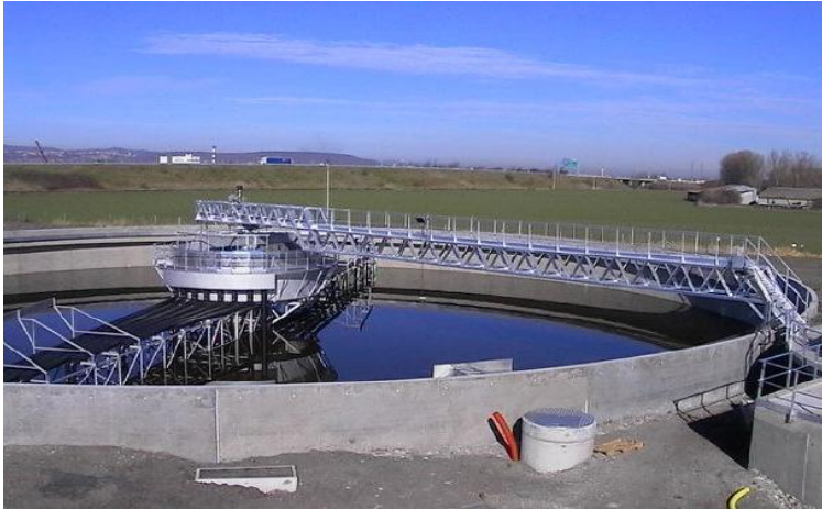
Figure I.13: décanteur secondaire circulaire (Atura équipement, pei ces de rechange, 2017)
