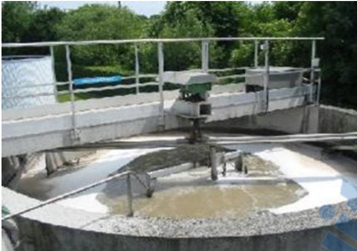
Figure I.7: Un bassin de dessablage-déshuilage circulaire (Module d'enseignement, 2017)
