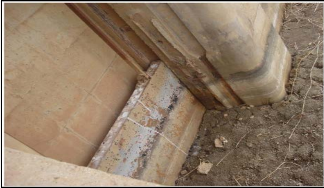
Photo.I.6. Blocage des vannes de fond (Remini, 2011)
