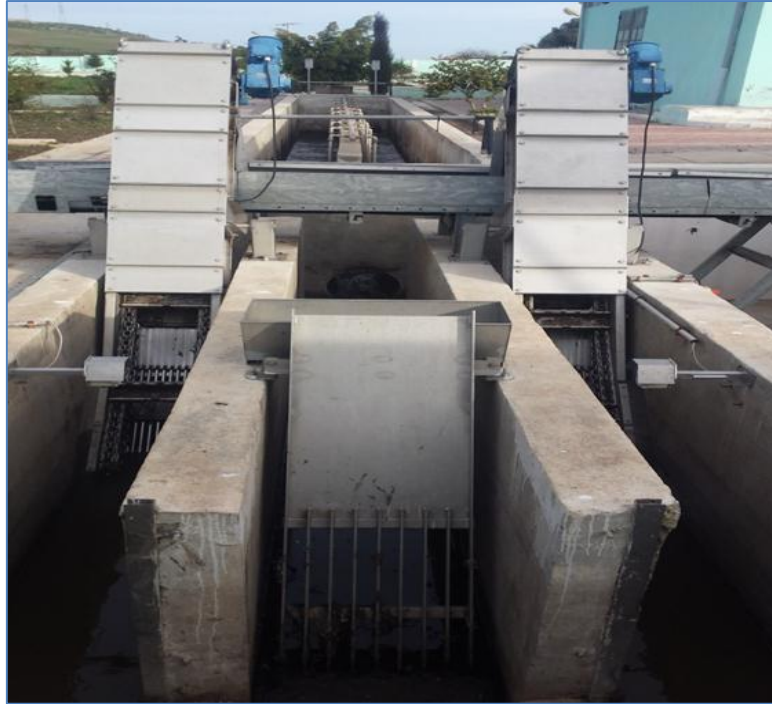
Figure III.5 : Photo de Dégrilleur.
