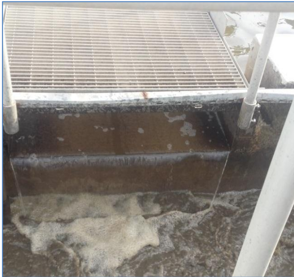
Figure III.8: Photo de l'arrivée de liqueur mixte recyclée du clarificateur au bassin sélectif .
