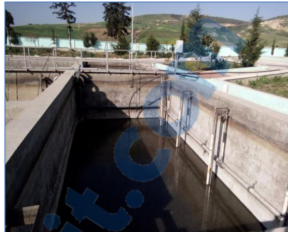
Figure III.16: Digesteur aérobie évidé.
