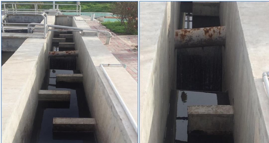
Figure III.18 : Photo du bassin de desinfection.
