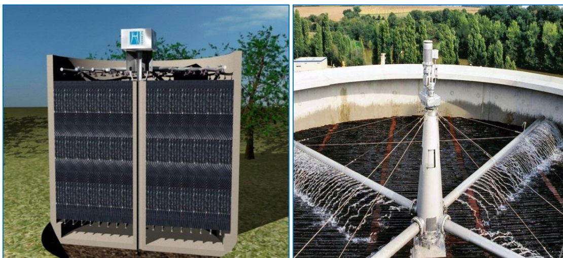
Figure I.6: Photo d'un support et sprinklers pour lits bactériens [52].
