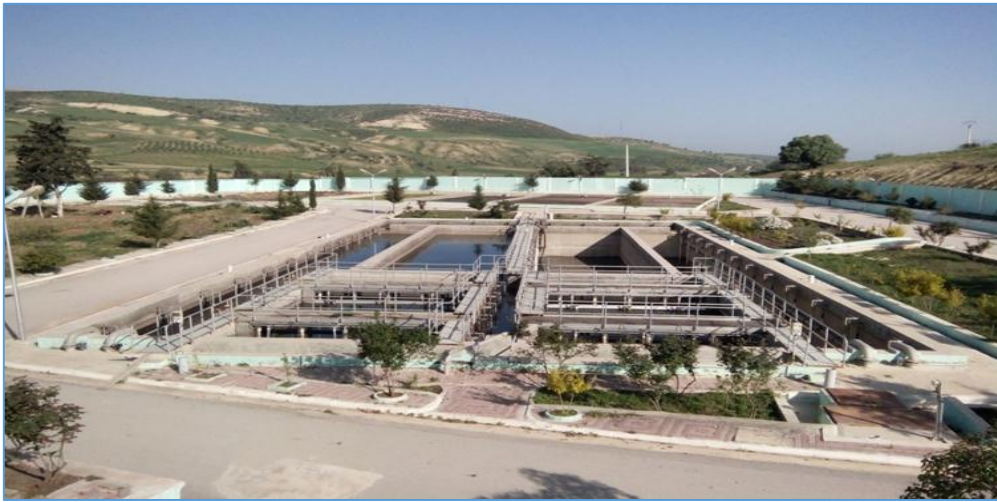
Figure III.1 : Bassin de traitement biologique de la station de Ain Tolba.
