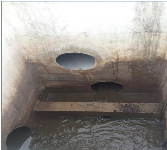
Figure III.3: Photo de bassin d'entrée (déversoir).
