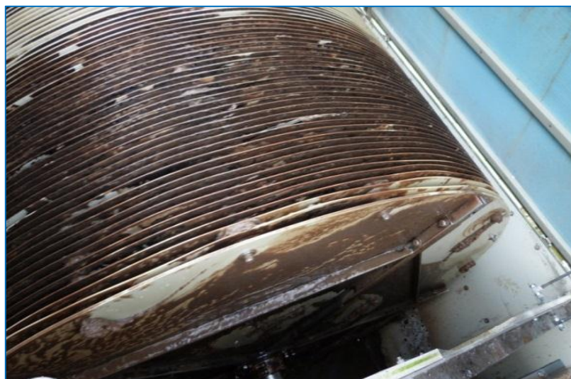
Figure I.8: Disque biologique ouvert [55].
