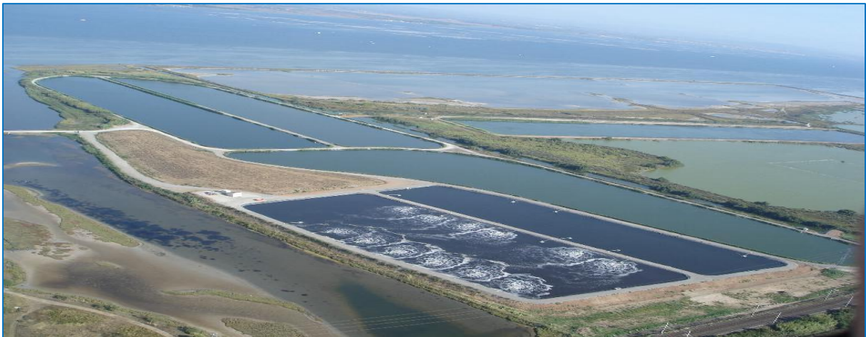
Figure I.10: Photo de bassins de lagunage aéré [59].
