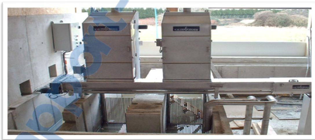
Figure I.2 : Photo d'un dégrilleur automatique vertical [41].
