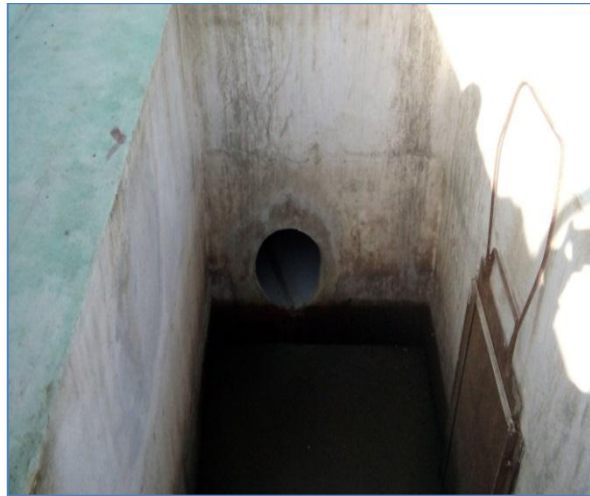
Figure III.4: Photo controle de débit avec la vanne batardeau.
