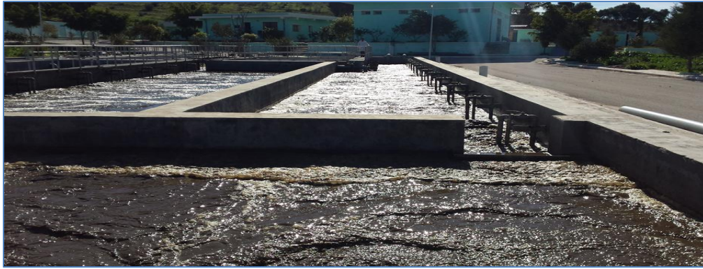
Figure III.14 : Photo de vue de bassin de digestion avec sa lame déversant vers le bassin d'aération secondaire B2.
