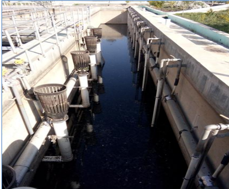
Figure III.12 : Photo de bassin d'aération secondaire A2 vide avec les diffuseurs submergés et les grilles d'entrée de clarificateur.
