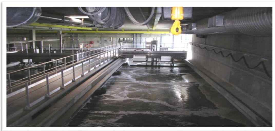
Figure I.4 : Photo d'un bassin de dessablage – dégraissage [45].
