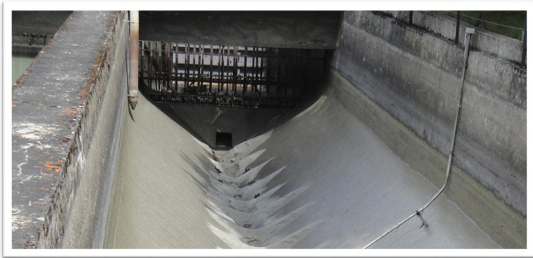
Figure I.3 : Photo d'un dessableur rectangulaire [43].
