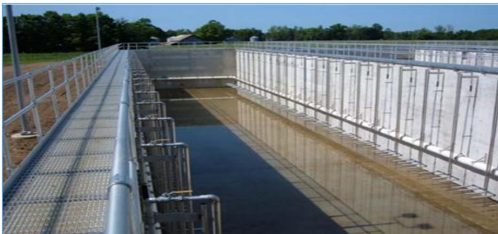
Figure II.6 : Bassin d'aération primaire technologie SEQUOX [77].
