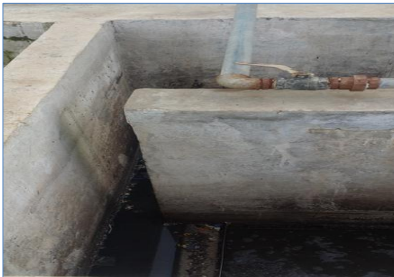
Figure III.6 : La photo montre la lame déversant des huiles de la réservation de vidange des graisses.
