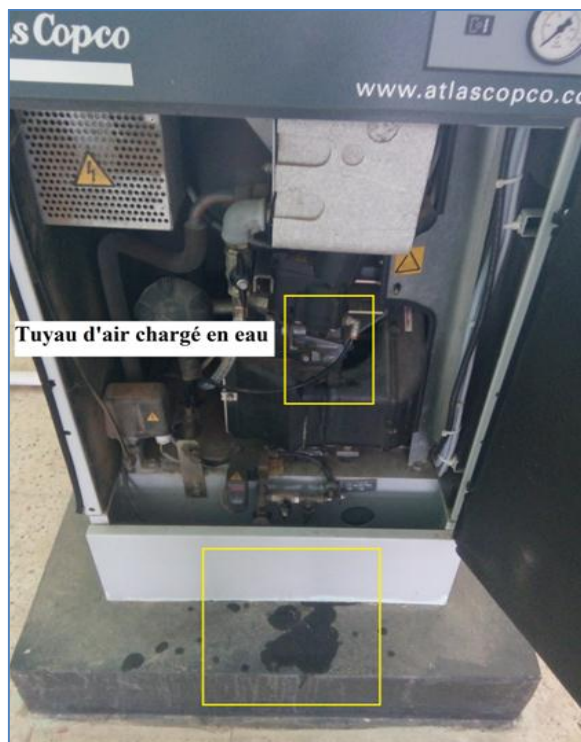
Figure V.36 : La photo de surpresseur d'air chargé d'eau.
