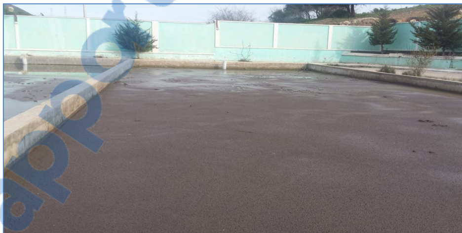
Figure III.17 : Photo de lit de séchage.
