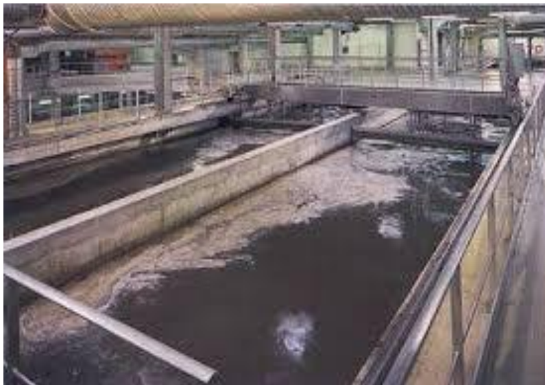
Figure II.3 : Dessableur-dégraisseur rectangulaire [32]
