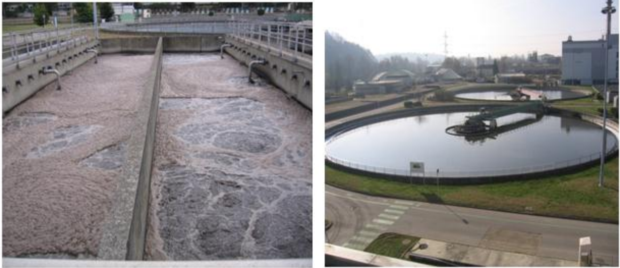
Figure II.5. Bassin d'aération (à gauche) et les décanteurs secondaires (à droite)[38].
