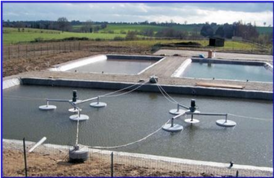
FigureII.9 : Photo de bassins de lagunage aéré [48]
