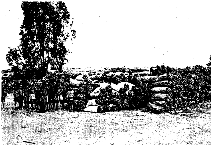
Photo 10 : Piles de sacs de charbon au dépôt d'Ambalambakisiny
