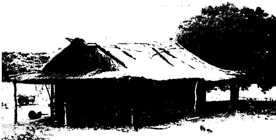
Photo 6 : Maison achevée : Plus d'une dizaine d'espèces forestières ont été nécessaires à sa construction.
