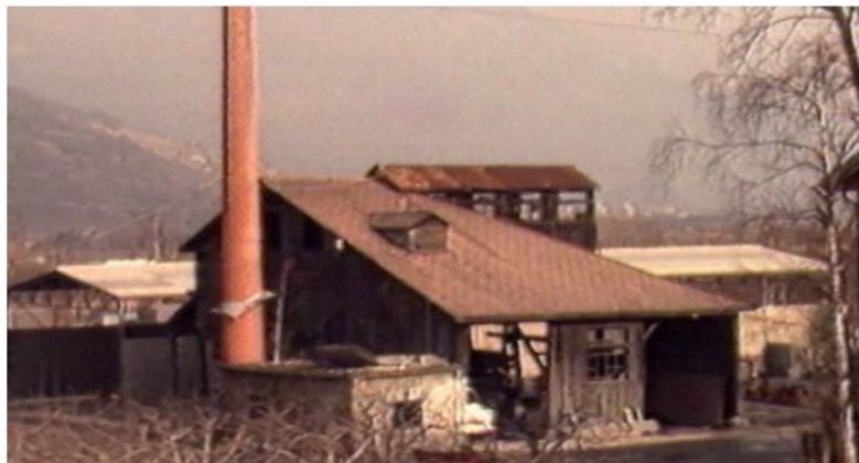
Les bâtiments de la mine de Grône en 1982. [RTS]
