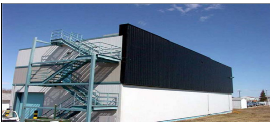
Figure 3.6 Station d'épuration des eaux usées: Alberta Cold Lake. Tirée de (RETSscreen, 2009)
