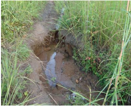
Photo 3: Erosion de piste de dessertes à Lama (Savalou) et Houin (Glazoué)
