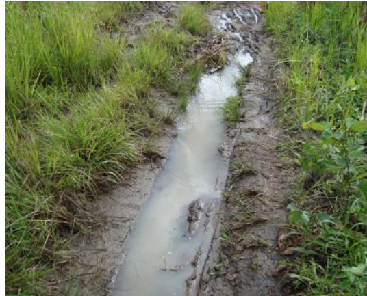
Photo 3: Erosion de piste de dessertes à Lama (Savalou) et Houin (Glazoué)
