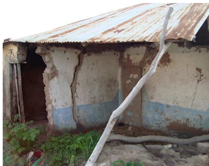
Photo N°6: démolissage d'une maison sous l'effet de la violence des pluies et vents.
