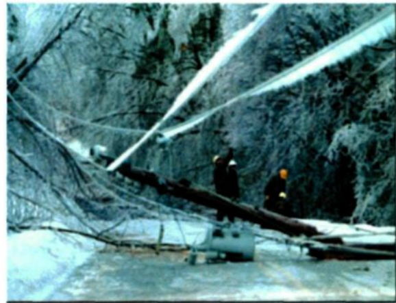
Figure 1.2: Équipe intervenant sur des câbles rompus à cause du poids de la glace accumulée (VPR 2008)
