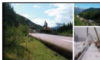
Figure 11 : Installation des pipelines suivant les normes canadiennes
